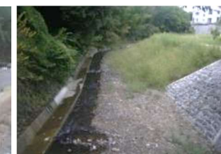
環境に配慮した護岸
