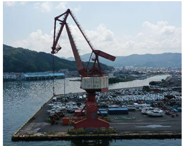
第2ふ頭の老朽化した多目的クレーンの更新
