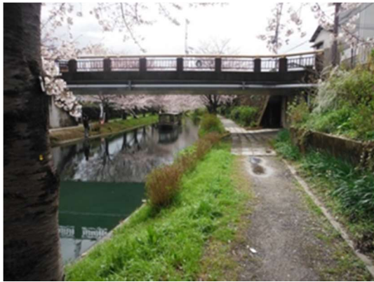
伏見港の園路再整備
