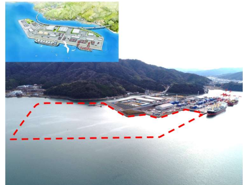
舞鶴国際ふ頭Ⅱ期整備
