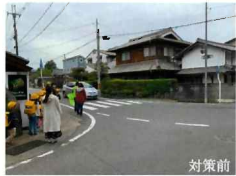
一般府道東掛小林線（亀岡市曾我部町） 対策内容：交差点改良 1箇所
