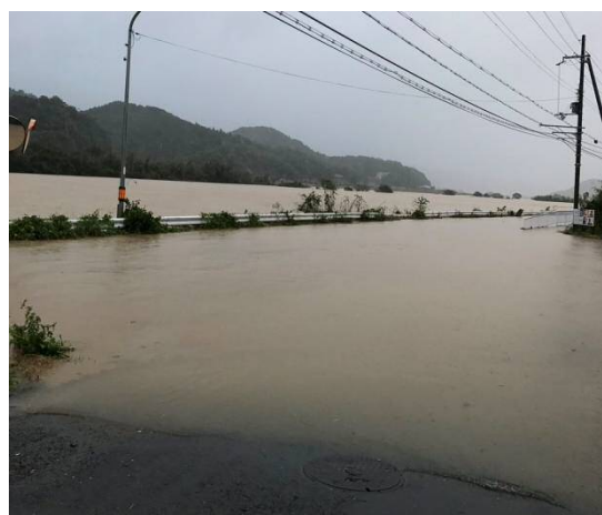
由良川増水に伴う国道175号浸水状況
