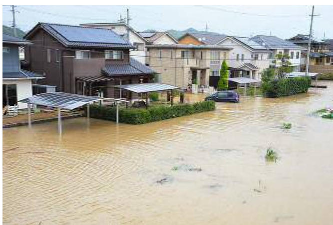
福知山市石原地区 浸水状況
