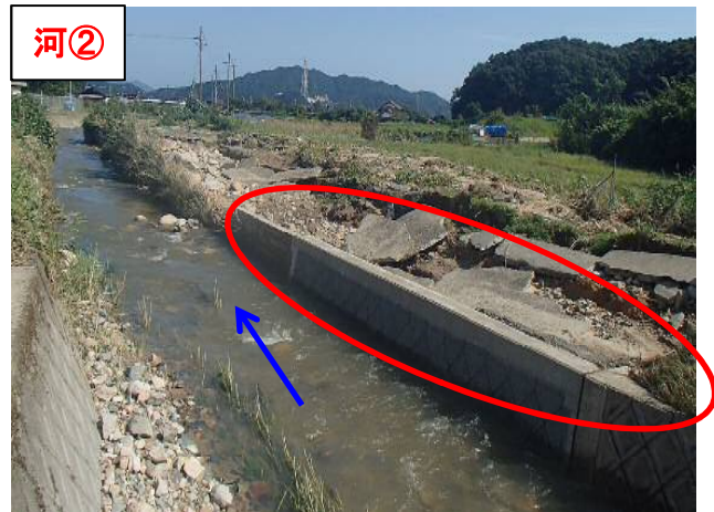
河② 【場 所】 みやづし 宮津市 おおくもがわ 二級河川 大雲川 【被災状況】河岸浸食 延長 535m (6 箇所 18 工区) 【復旧内容】ブロック積工 260,000 千円
