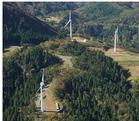
図 1-5 太鼓山風力発電所
