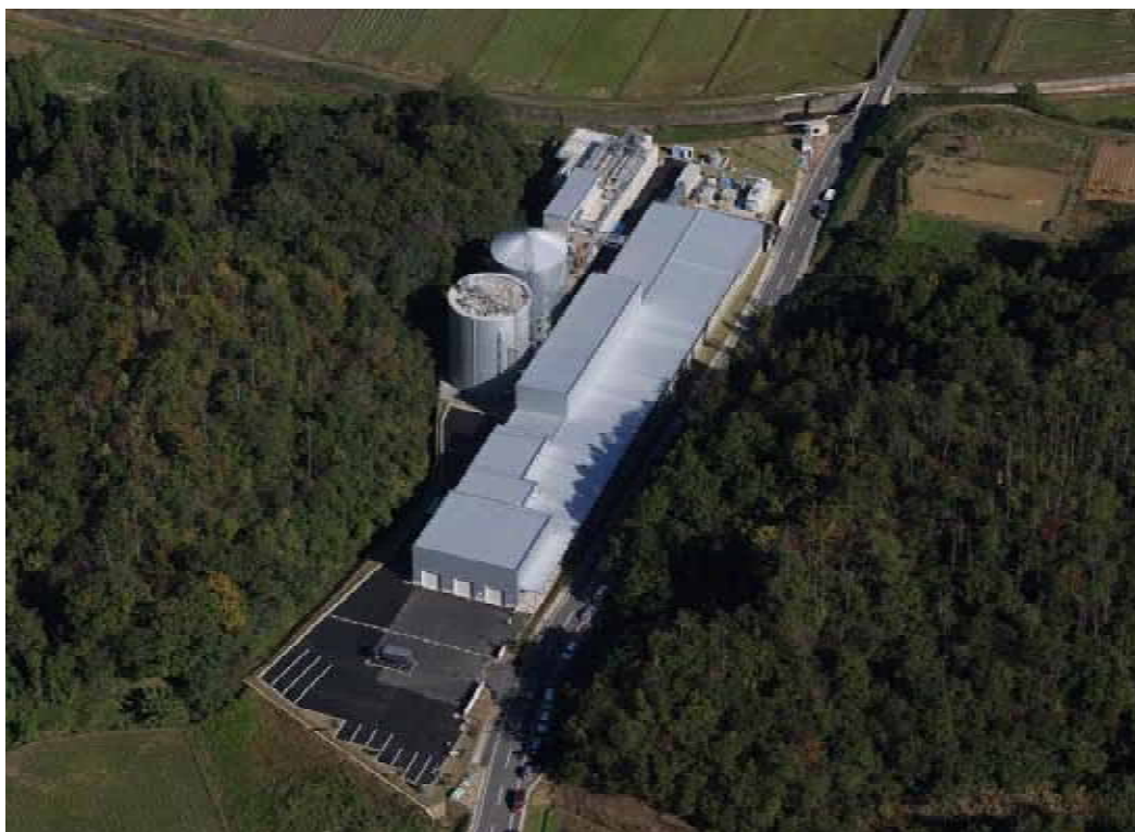
図3 - 6 バイオガス発電設備(京都エコエネルギー研究センター)
