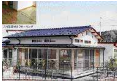
府営住宅への府内産材利用
