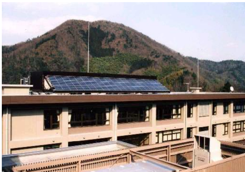
図1-6 舞鶴養護学校（17年度開校）に設置された10kWの太陽光発電施設
