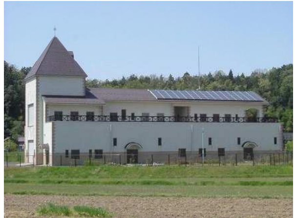
太陽光発電設備 (溝谷・吉野地区農業集落排水処理施設)
