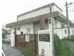
導水ポンプ所
