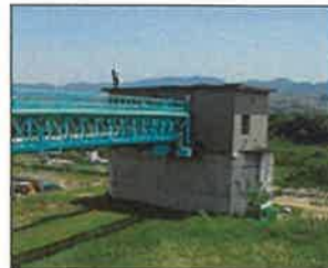
取水ポンプ棟
