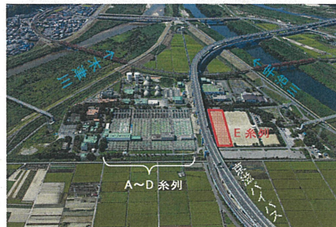
◎洛南浄化センター(航空写真)
