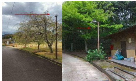
（整備前の照明）
