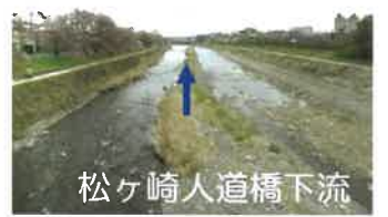
H21及びH30施工
