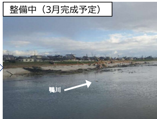
低水護岸の整備
