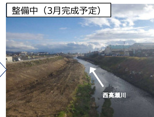
高水護岸・低水護岸の整備
