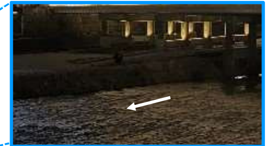
三条大橋下流右岸 橋桁下
