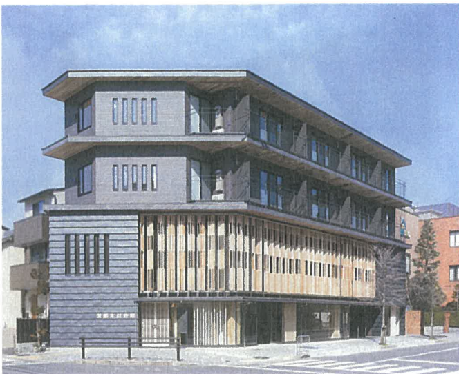
京都木材協同組合会館 木造4階建てで耐火構造仕様(COOL WOOD)
