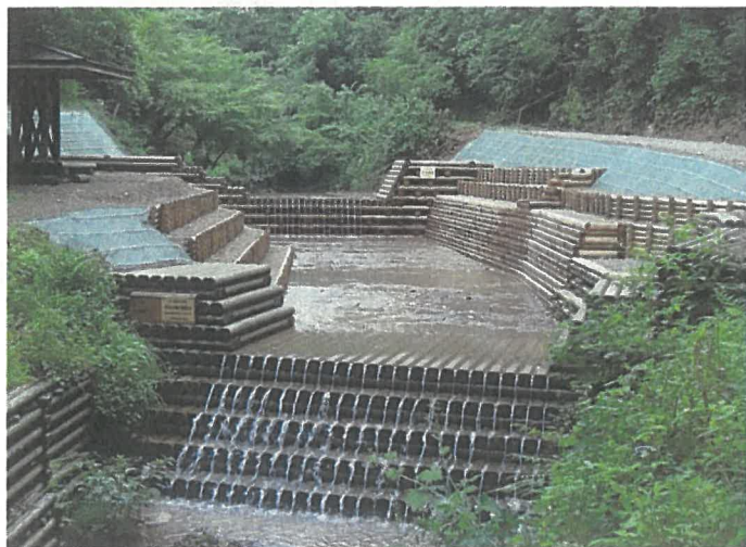
木製治山ダム
