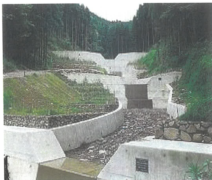
溪流工事(溪床の安定・山脚の固定等)
