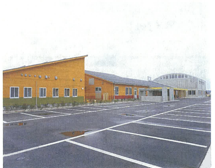
京丹後市立大宮保育園 京都府初の大型木造建築物 木材使用量 485m 3
