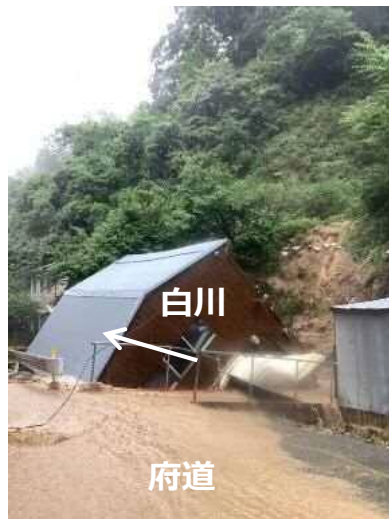
斜面崩落による家屋の倒壊（河川内に落下）
