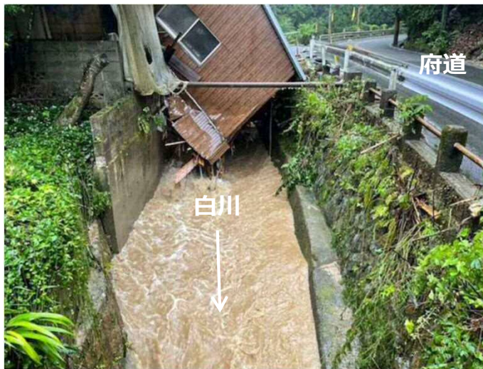
斜面崩落による家屋の倒壊（河川内に落下）
