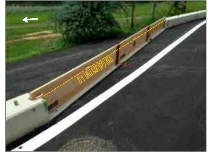
計画堤防高までのパラペット堤防と 河川進入路の板柵を整備
