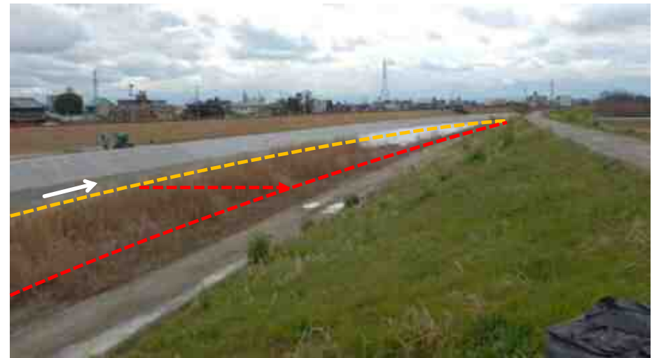
低水護岸の引堤
