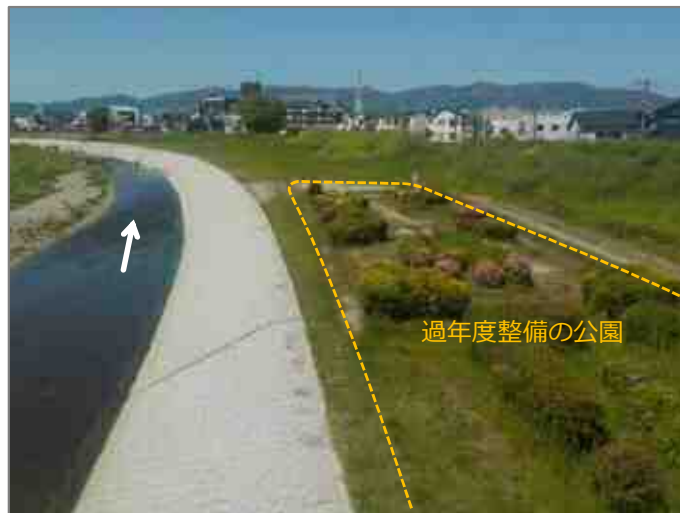
低水護岸を整備 園路は上流工区と一体で整備予定
