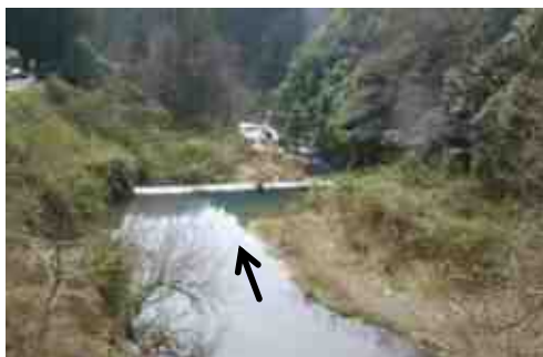
中津川向山砂防えん堤（整備前）
