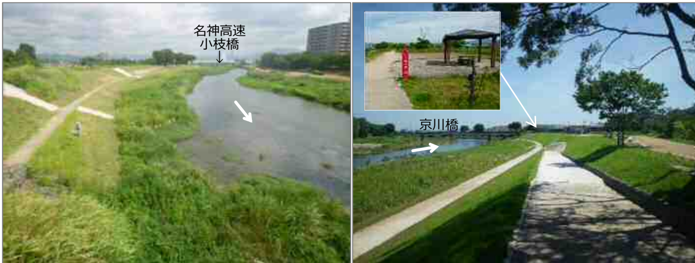
低水護岸(覆土あり)・高水護岸・園路 親水階段護岸を整備
