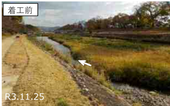
〈R3実施〉上加茂橋下流
