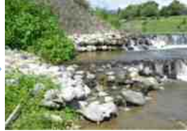
練積みで再設置（H30.3施工） 平成30年7月豪雨で大きな損傷なし
