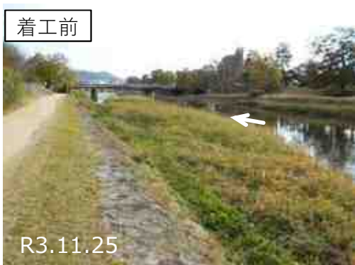
〈R3実施〉葵橋上流
