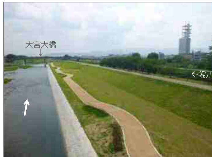
低水護岸・高水護岸・園路を整備 火打形橋(堀川)を整備により園路を下流に延伸
