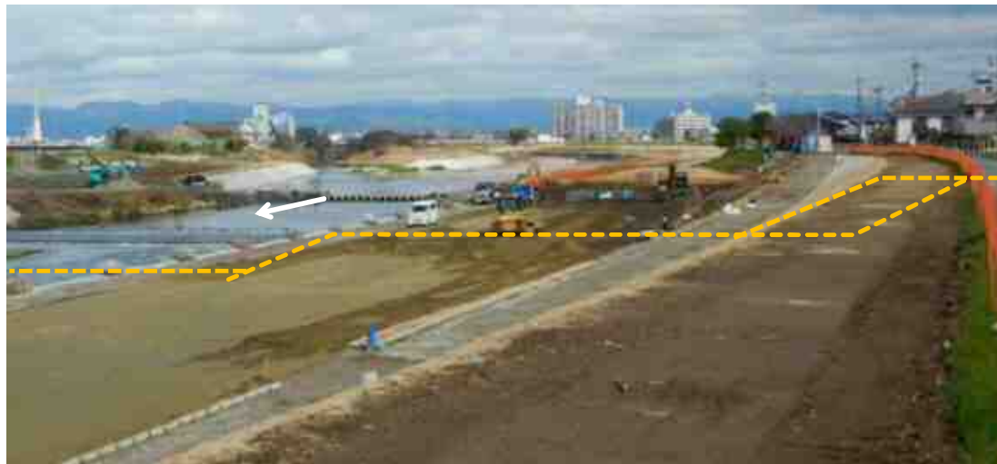
護岸整備・龍門堰撤去 (階段式魚道を全面に設置し、縦断の連続性を確保)
