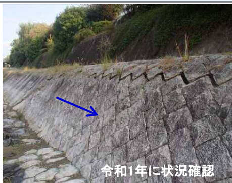
空洞化した護岸の復旧（三条大橋下流左岸）
