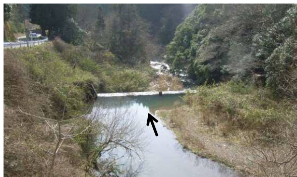
中津川向山砂防堰堤(整備前)
