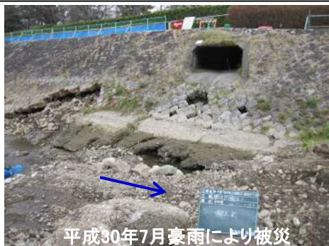
崩落した護岸の修繕（荒神橋上流右岸）
