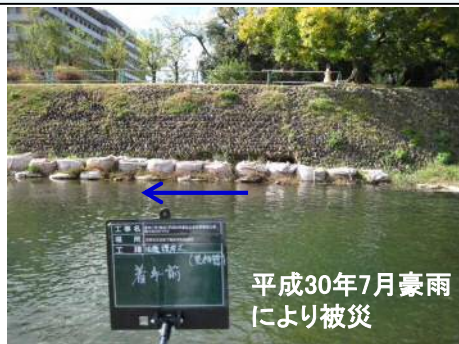
空洞化した護岸の復旧（三条大橋下流左岸）
