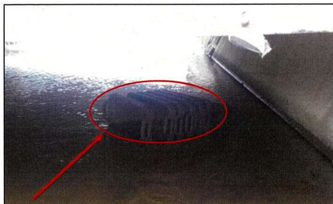
投げ捨てられたプランター
