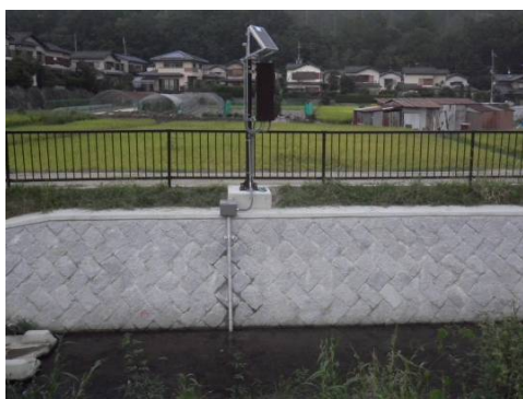
水位計の設置事例（長代川）
