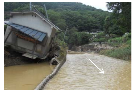
志津川の被災状況
