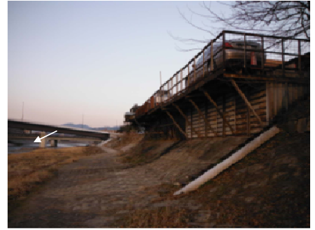
勸進橋上流左岸
