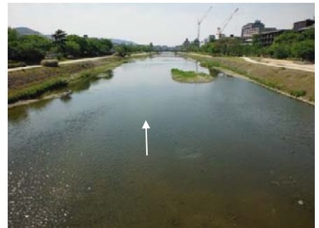
河床整正前後の状況（丸太町橋下流）
