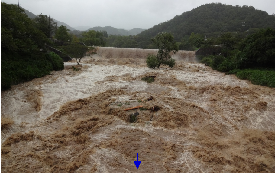
柘野堰堤下流側
