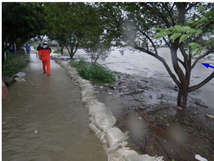
堤防からの溢水
