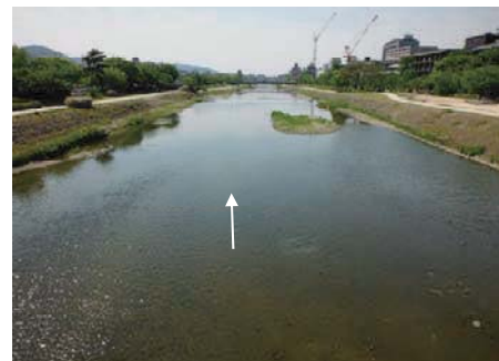
河床整正の状況（丸太町橋下流）
