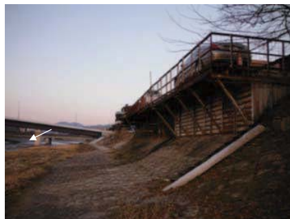
勧進橋上流左岸
