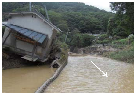
志津川の被災状況
