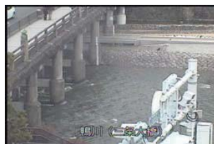
CCTVの画像(昼間)
