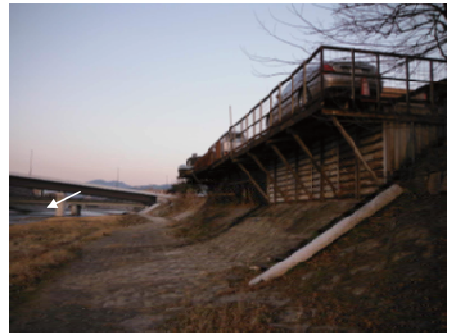
勧進橋上流左岸
