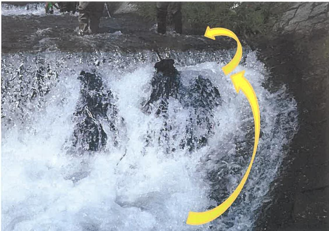
② 丸太町落差工（左岸）～木組み階段式魚道～
