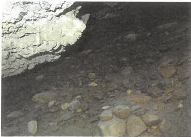
上流側: 護岸裏側の空洞(奥行き約1.0m)
