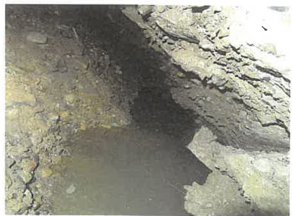
下流側: 護岸裏側の空洞(奥行き約0.7m)
