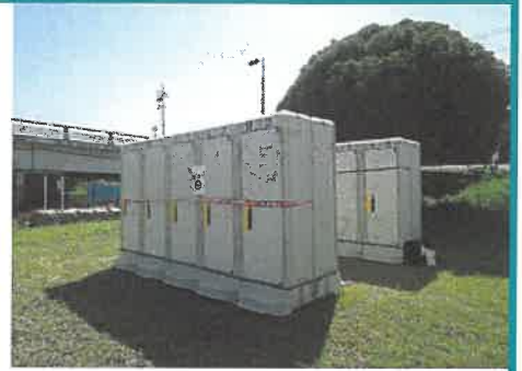
仮設トイレ(男子5基・女子5基)
