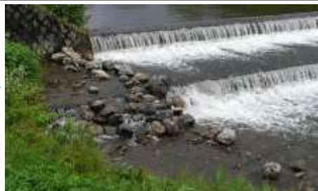
大雨により損傷(H29.7.1)
