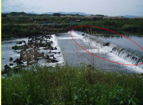
堰本体上部の撤去 平成27年1月
