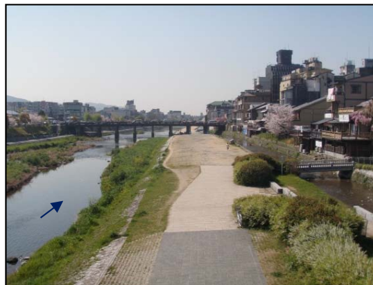
御池大橋下流 (左:H21.4)
