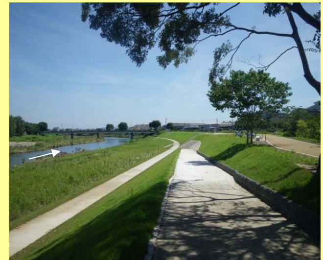
京川橋上流(西高瀬川背割り堤) 小枝橋公園 平成25年4月完成
