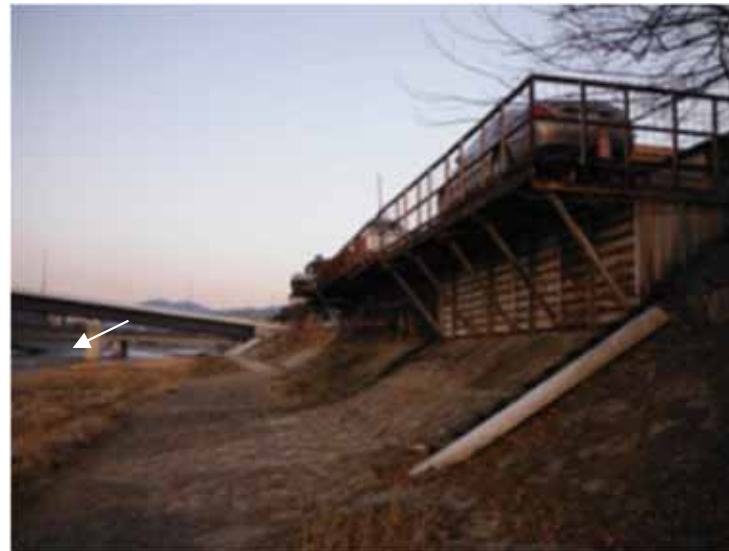
勧進橋上流左岸
