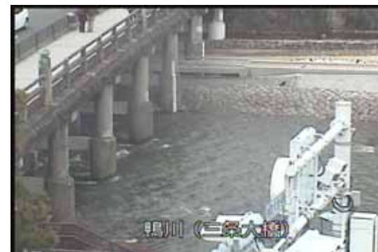
CCTVの画像(昼間)
