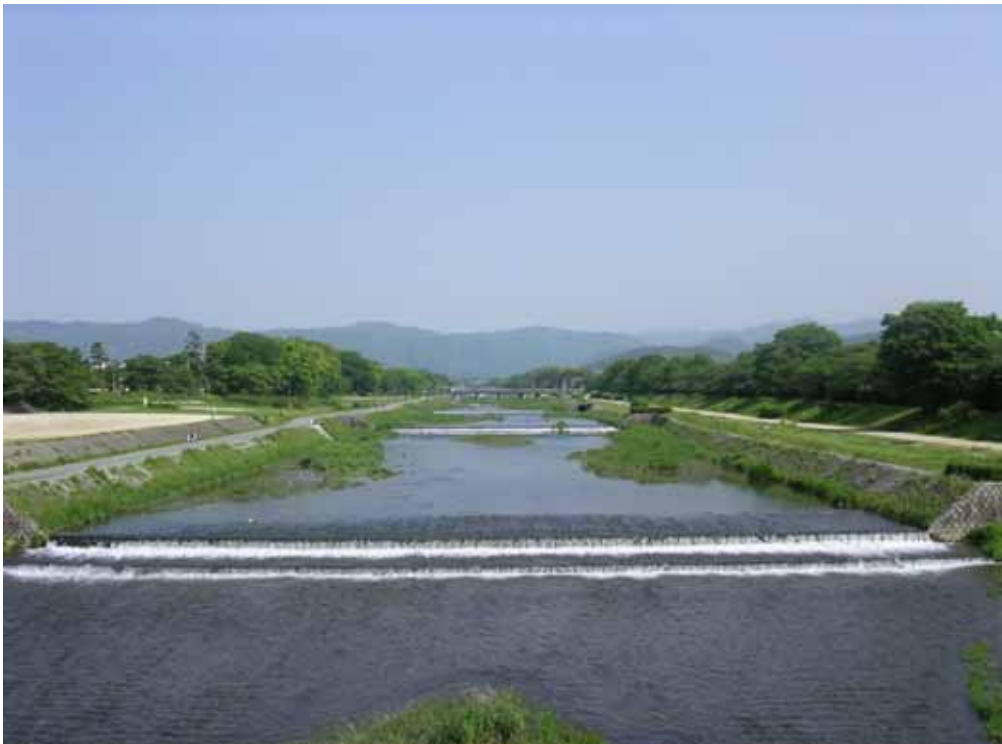
出雲路橋上流から望む落差工
