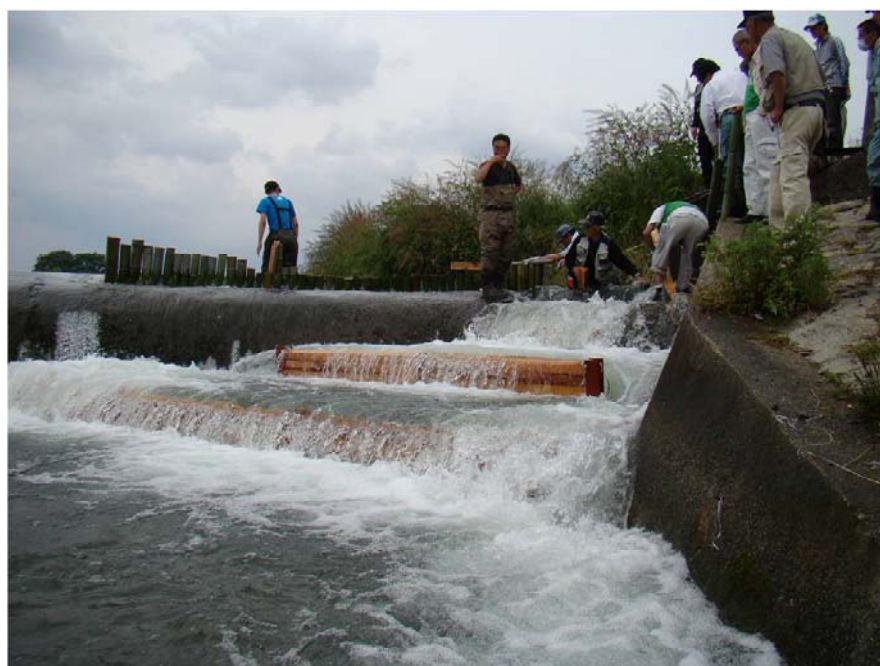
魚道設置作業
