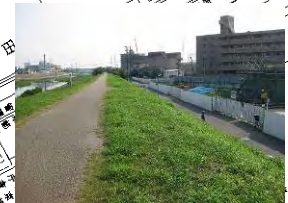
堤防天端（カラー舗装整備済み）
