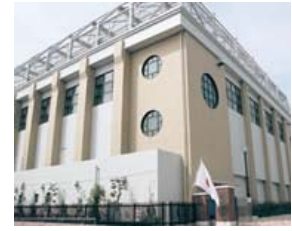
公共施設での雨水利用施設その2 (京都府立山城高等学校)
