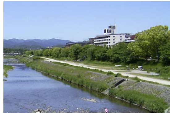
護岸の写真(荒神橋付近)
