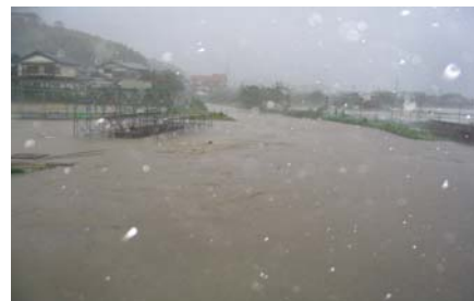
台風16年台風23号による大手川の氾濫状況
