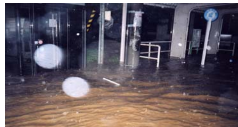
台風16年台風23号による浸水状況 (宮津市)
