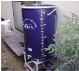
既に京都市で助成金制度が確立されている戸建て住宅での雨水利用施設 (京都市上下水道局HPより)
