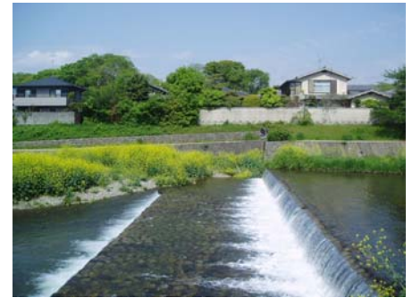
高野川 御蔭橋～河合橋
