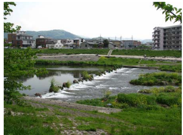
鴨川 勸進橋～水鶏橋
