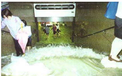
地下鉄博多駅入口より流入する氾濫水
