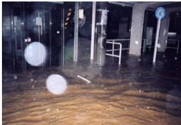
平成16年台風23号による浸水状況（宮津市）
