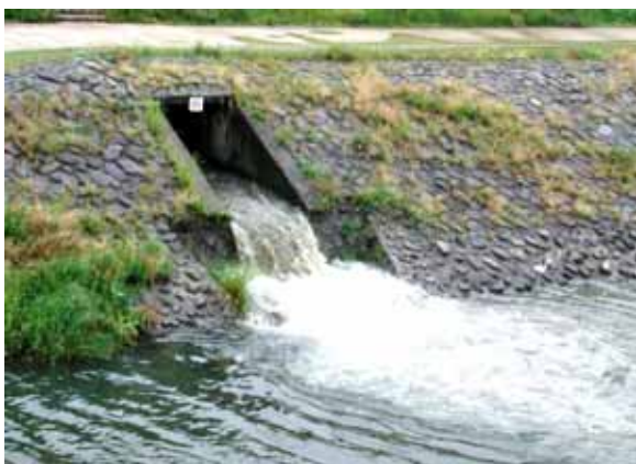
合流式下水道からの雨天時放流水
