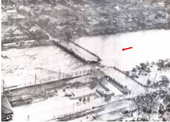
三条大橋の流失状況
