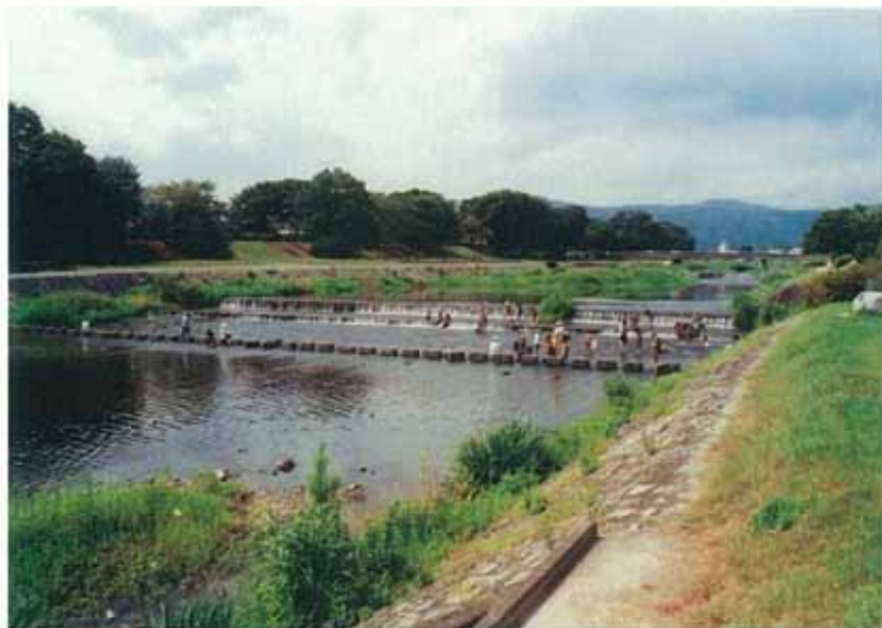
北山大橋下流
