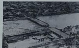
流出した三条大橋
