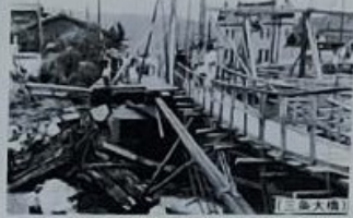
三条大橋の仮設橋
