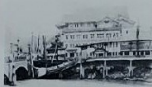
京阪四条駅ホーム崩落
