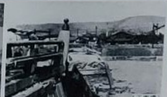
正面橋流失/右岸南詰より撮影
