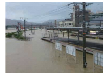
平成25年台風18号 JR亀岡駅の浸水状況
