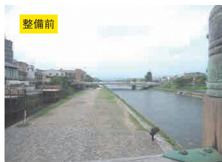
「緑の回廊」整備 御池大橋～三条大橋
