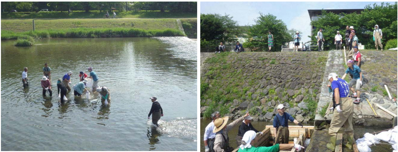
H30.5.1 荒神口魚道設置作業の様子
