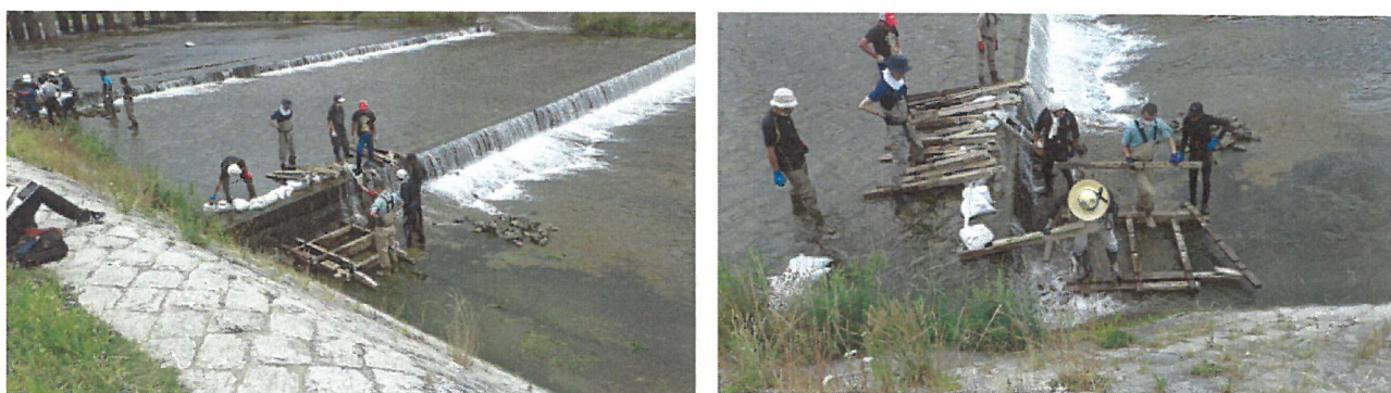
令和2.6.10 三条魚道設置作業の様子
