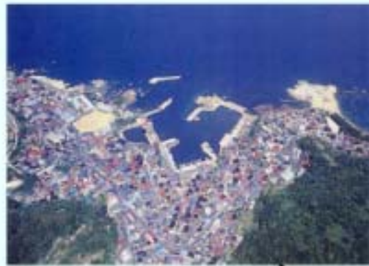
間人漁港 丹後の流通拠点基地港。港口が波浪方向を向いているため、冬期の静穏度が確保しにくい。
