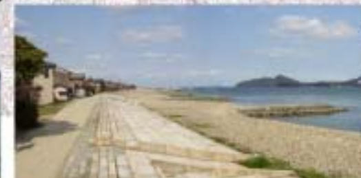
江尻海岸周辺 天橋立より一体的な護岸整備が進められている。
