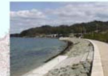
矢原周辺 護岸整備が進み、親水性護岸、階段、散策路などが整備されている。
