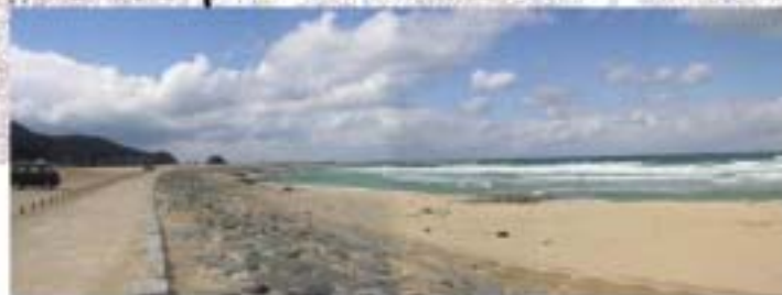
浅茂川海岸 親水性の遊歩道、突堤、駐車場、トイレなど、海岸及水辺育地の整備が進む。
