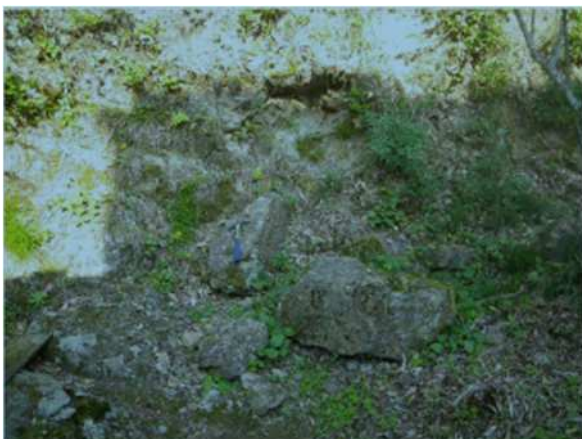
【写真番号⑰】 露岩状況 (8No.4 付近)
