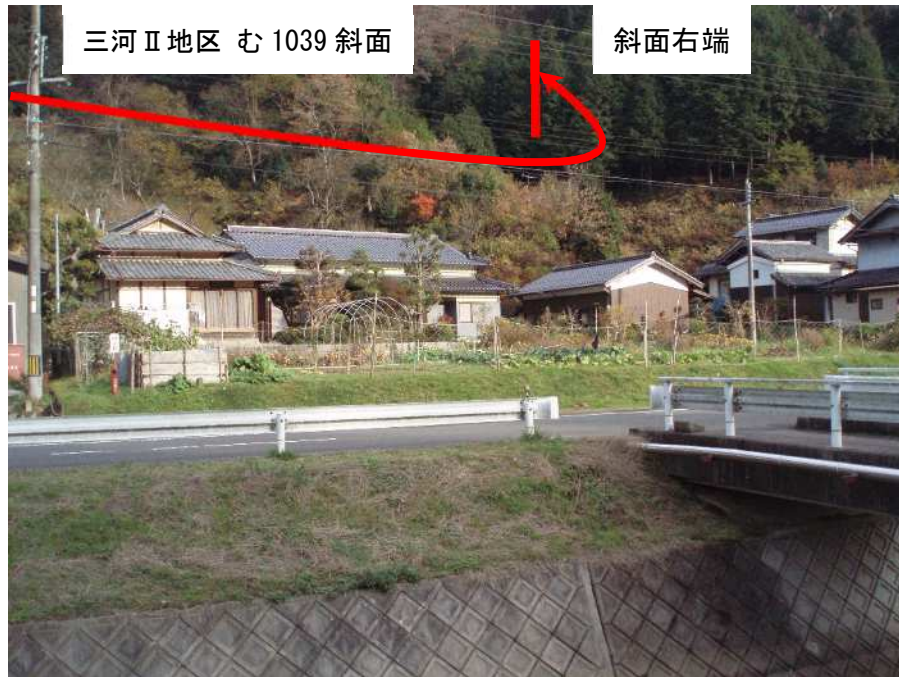
【写真番号④】 三河Ⅱ地区 ㊦ 1039 斜面 全景 右端付近
