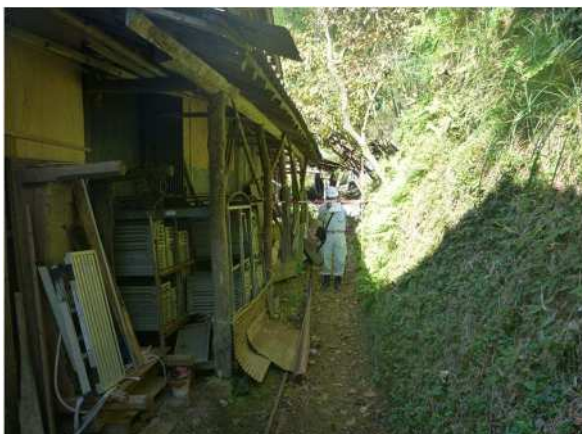
【写真番号⑪】 3No.3 付近の状況
