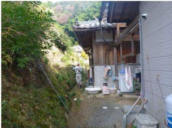
【写真番号⑨】 2No.3+10 付近の状況
