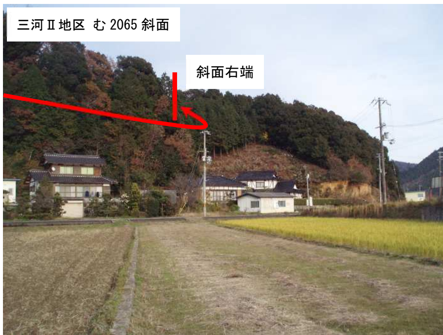
【写真番号⑥】 三河Ⅱ地区 む 2065 斜面 全景 右端付近
