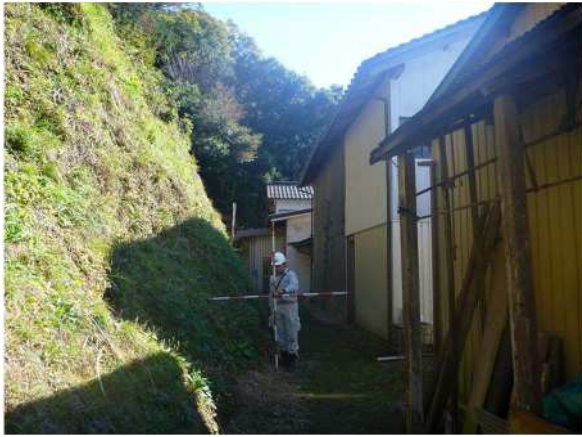
【写真番号⑦】 1No.1+10 付近の状況
