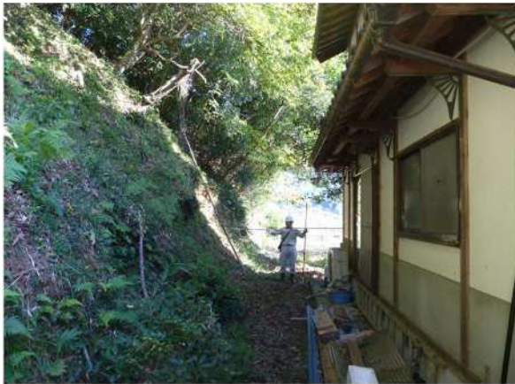
【写真番号⑮】 8No.4 付近の状況
