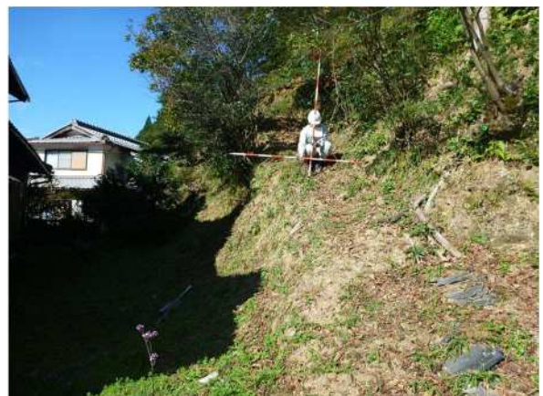
【写真番号⑫】 3No.4 付近の状況
