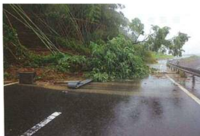
【写真-4 山側崩壊 (H30. 7. 7 連続雨量 439mm)】
