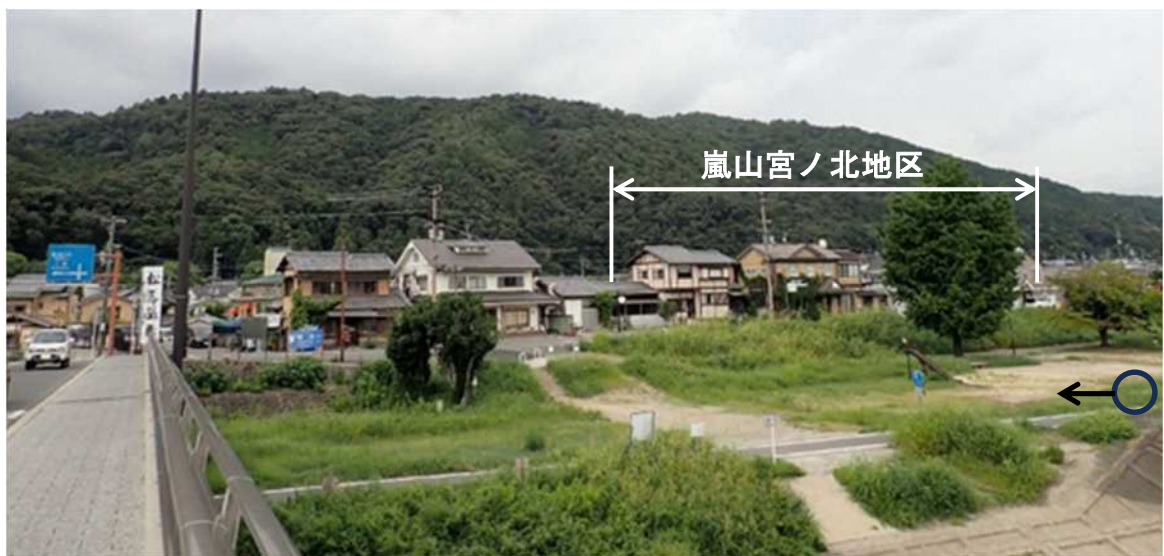
写真- 1 事業箇所全景写真
