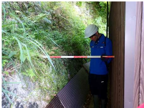
NO. 63 付近。人家と斜面との離隔が 1.2m 程度と近接している。
