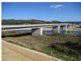
写真-6 木津川橋(ベージュ系塗装)
