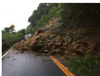
写真-5 国道163号落石・崩土
