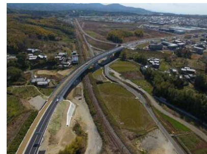
写真-2 鹿背山高架橋
