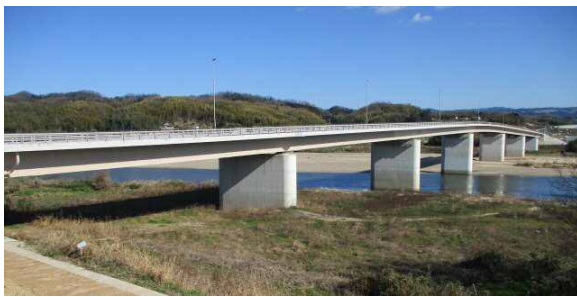
写真-1 木津川橋
