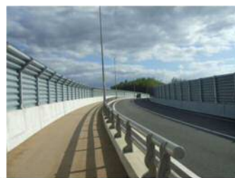
写真-7 歩道舗装(脱色アスファルト)
