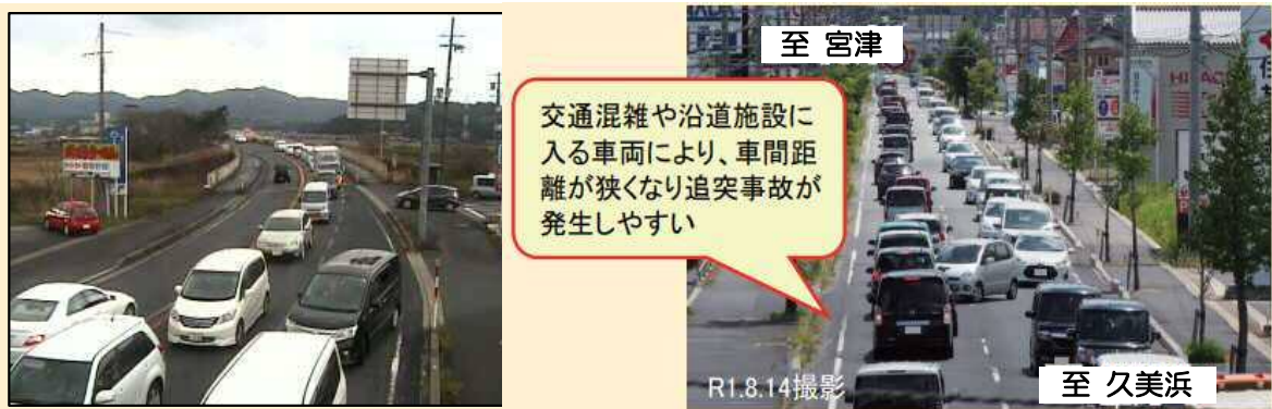
写真-2 長岡大橋交差点の状況
