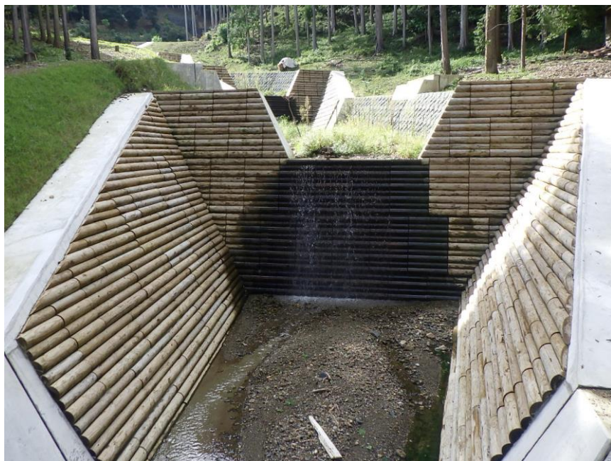
【写真：支川床固工】
