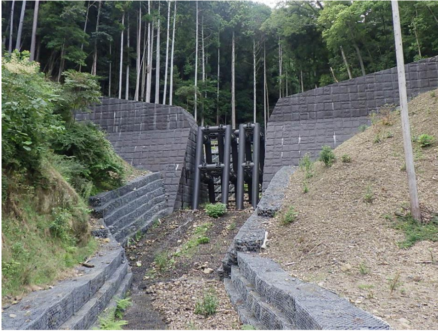
【写真：支川堰堤工】
