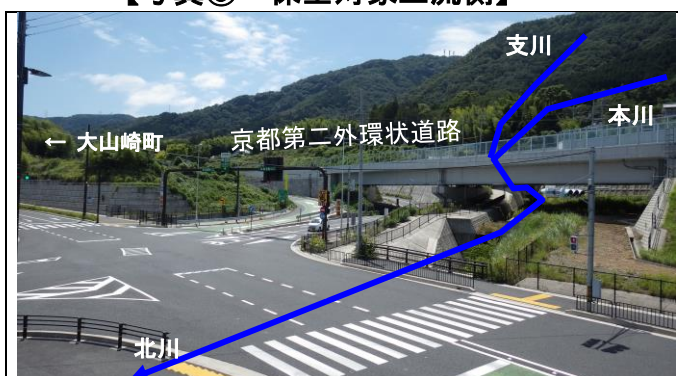
【写真⑪ 京都第二外環状道路下流側】
